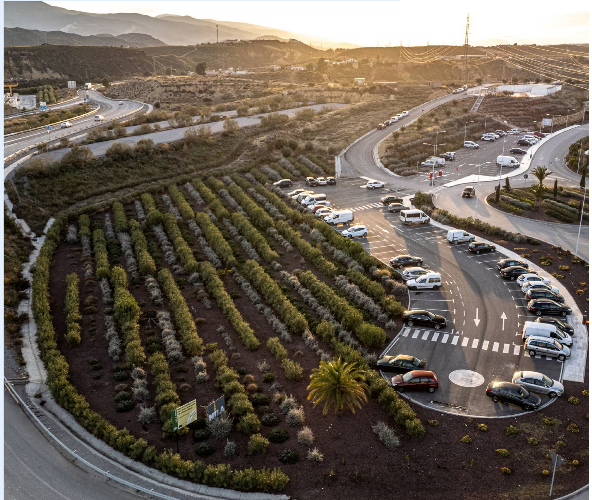
→ Planta de Tratamiento de Agua Industrial
